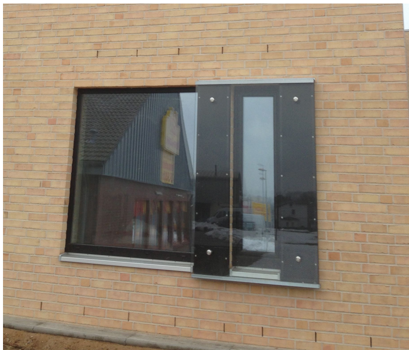
Abb. A 9.3: zwei seitlicher Absorber vor offenbarem Fenster in Kombination mit einem nicht offenbarem Fenster (aus schalltechnischer Untersuchung HUB 792.8432011 B aus 2011 Pflegeheim Travemünde Gnevendörfer Weg)
