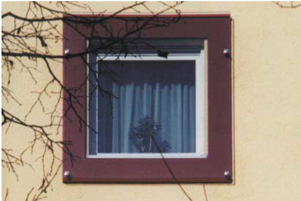
Abb. A 9.2: umlaufender Absorber Auszug aus Lärmschutzbaukasten München, 2005 [16]
